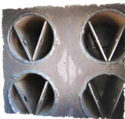
Рисунок 2 – Установка турбулизаторов
